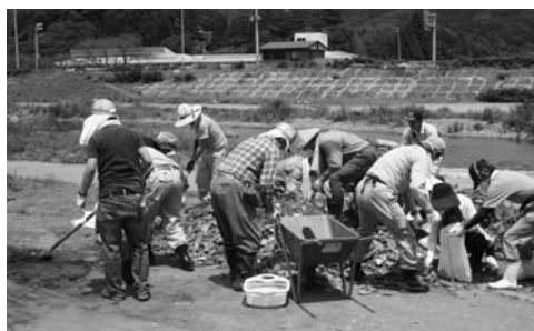
混在するガレキを分別する作業（鮭プロジェクトの河川清掃）
