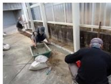
車庫、雨が吹き込んで水がたまる。溝を付けました。ブロックを壊して溝を作ることは難しいのではと思ったら、ブロックは無傷で、溝が完成。
