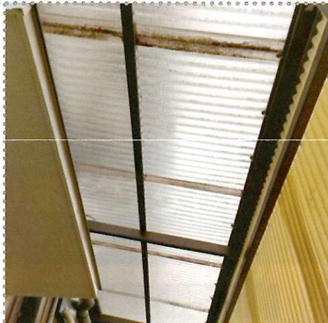
台風で外れた 波板の補修をしました
