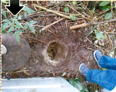
排水のつまり除去 つまり箇所を探索してい きました。流れ始めると、う れしいです。
